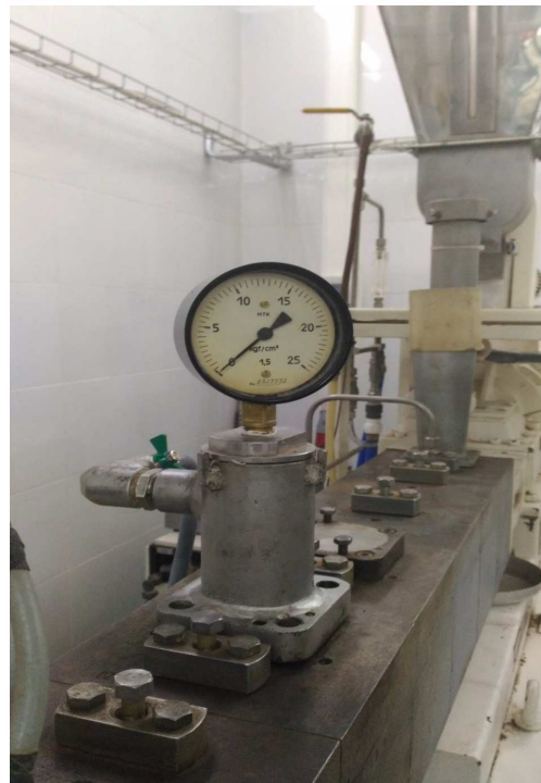
Рис. 2. Устройство отбора пара
